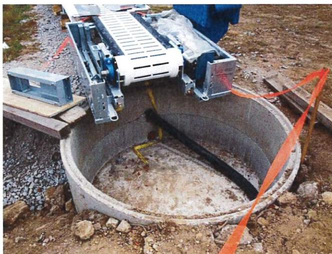
**Geplante Ausführung Förderbandgrube mit Fertigbetonringen**
